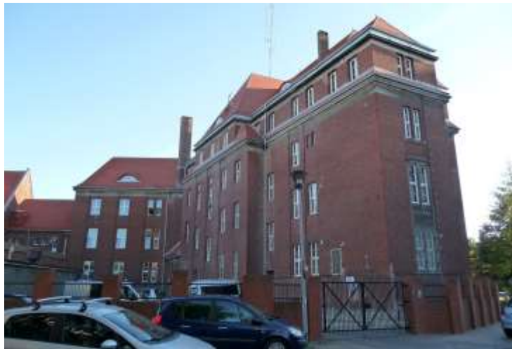
Widok budynku od północnego-wschodu
