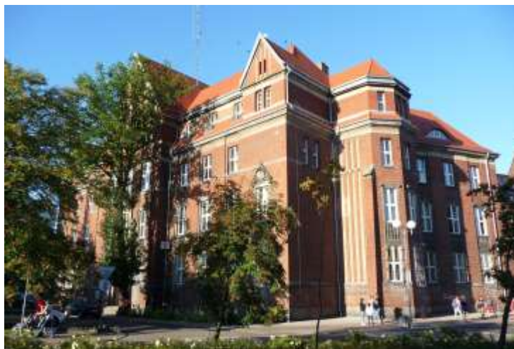
Widok budynku od południowo-zachodu
