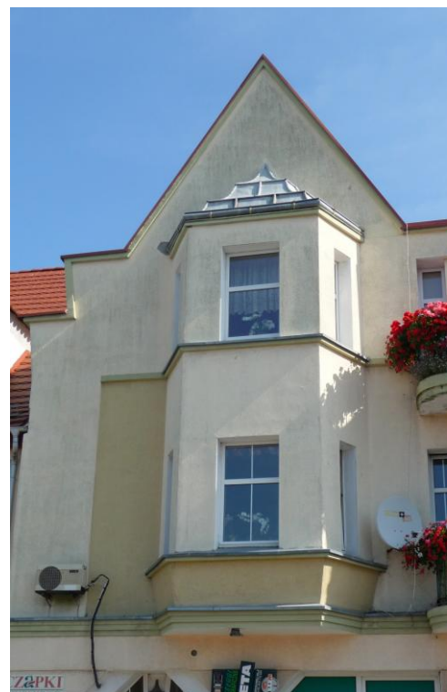
Wykusz w elewacji południowo-zachodniej
