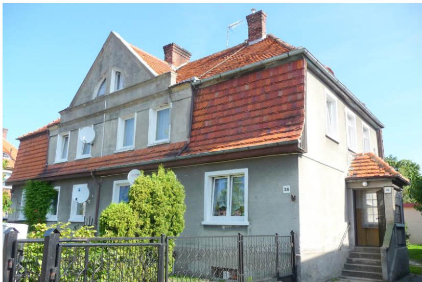
Widok budynku od południa
