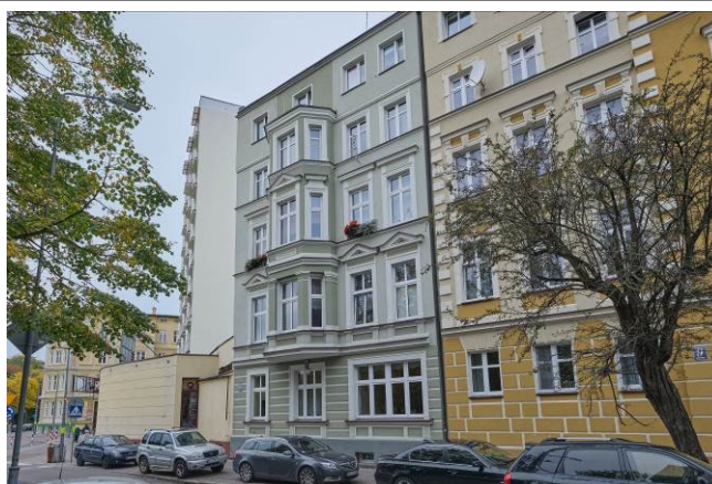
Widok na elewację frontową od strony południowo-wschodniej
