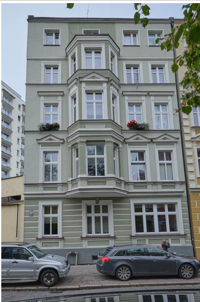
Elewacja frontowa, widok od strony południowej
