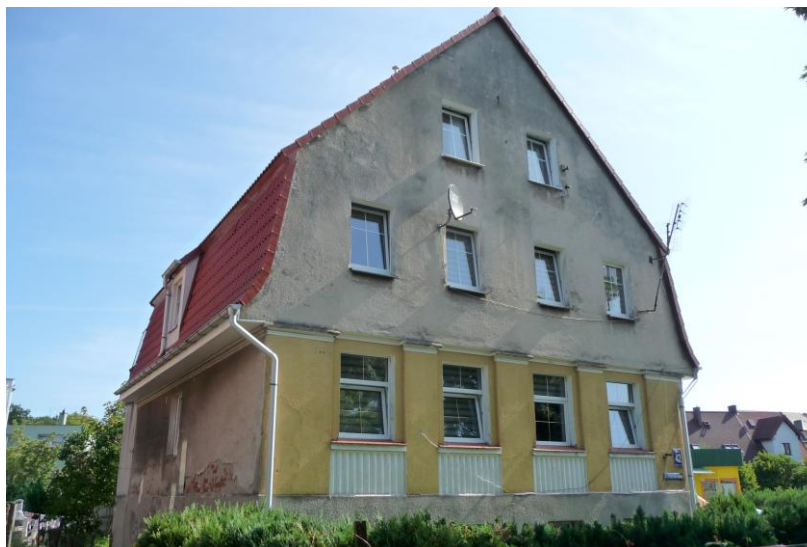
Widok budynku od południowo-zachodu
