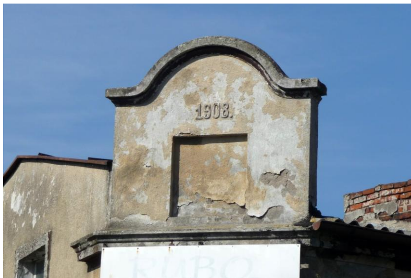
Murek kotarowy wieńczący wschodnie naroże budynku
