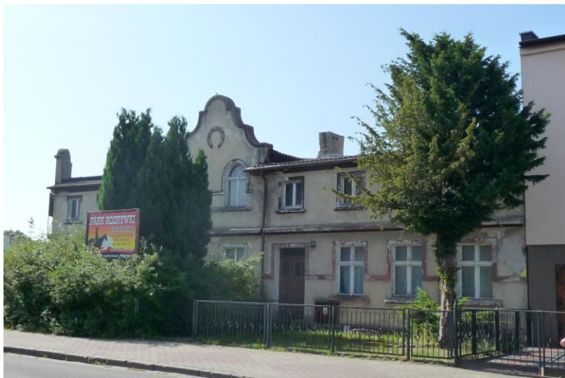
Widok budynku od północnego-wschodu
