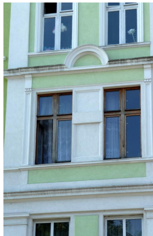
Otwory okienne elewacji północno-wschodniej
