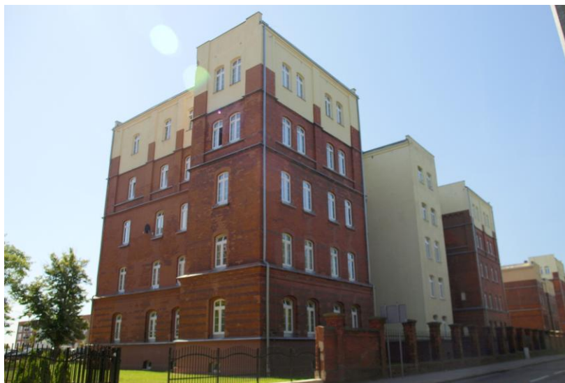
Widok budynku od wschodu
