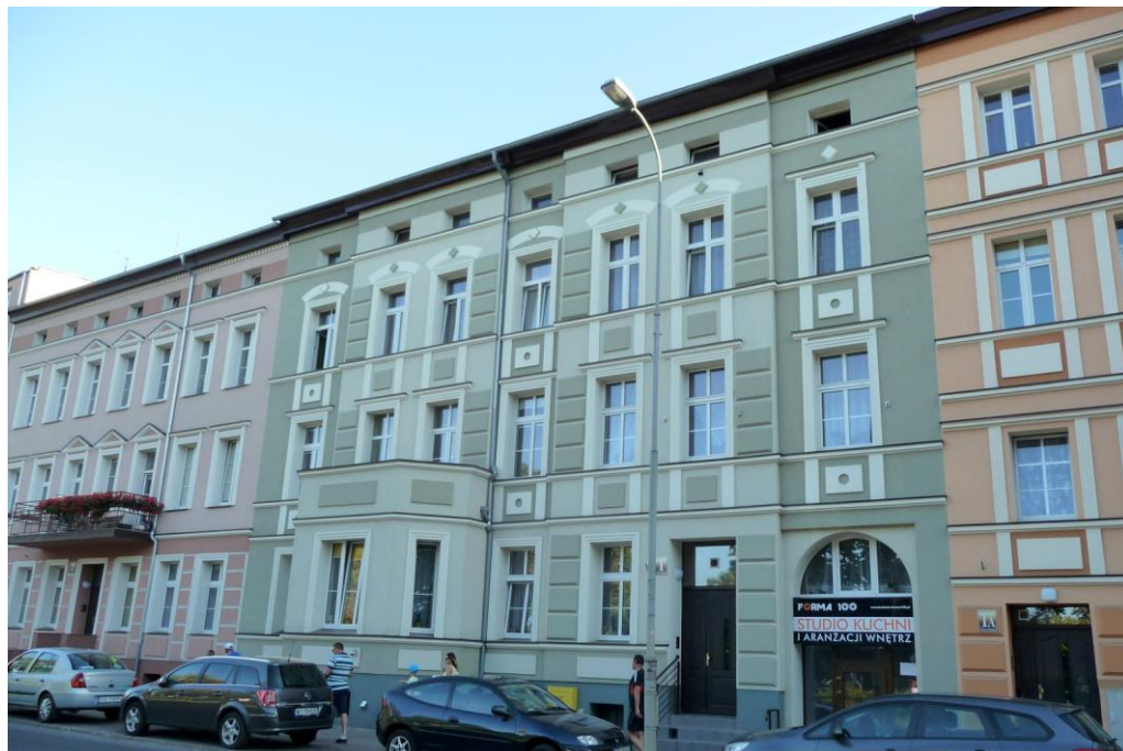
Widok budynku od północy
