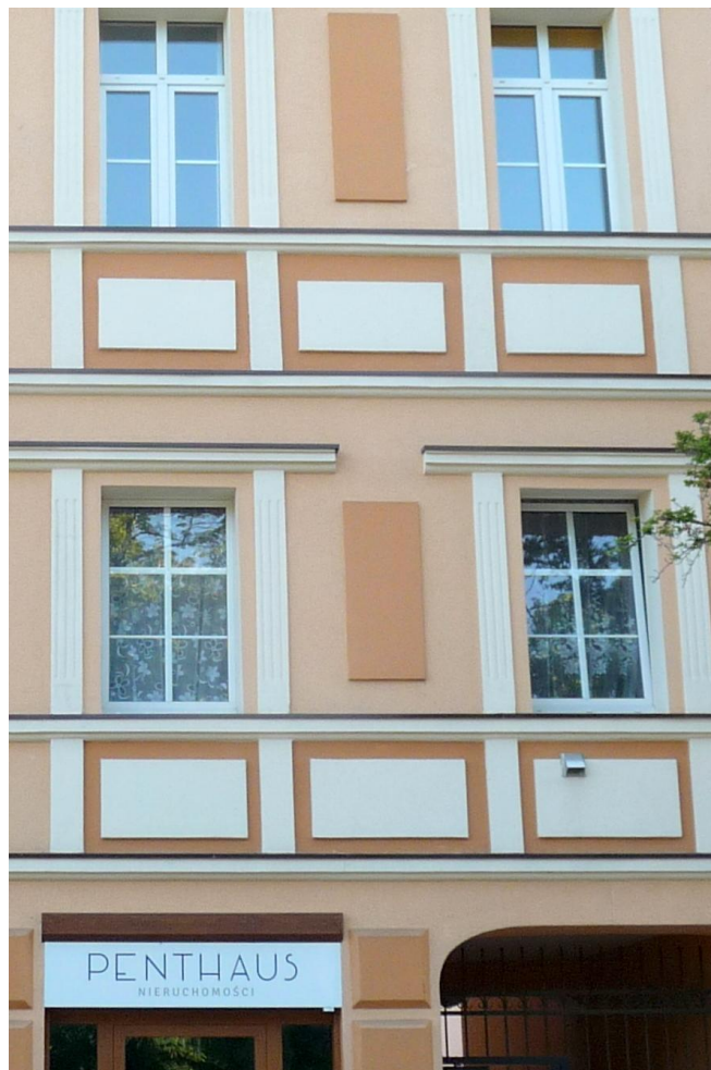
Otwory okienne elewacji frontowej
