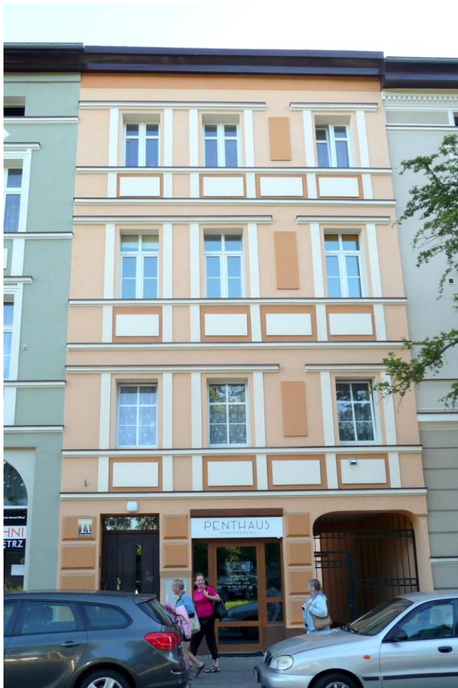
Widok budynku od północy
