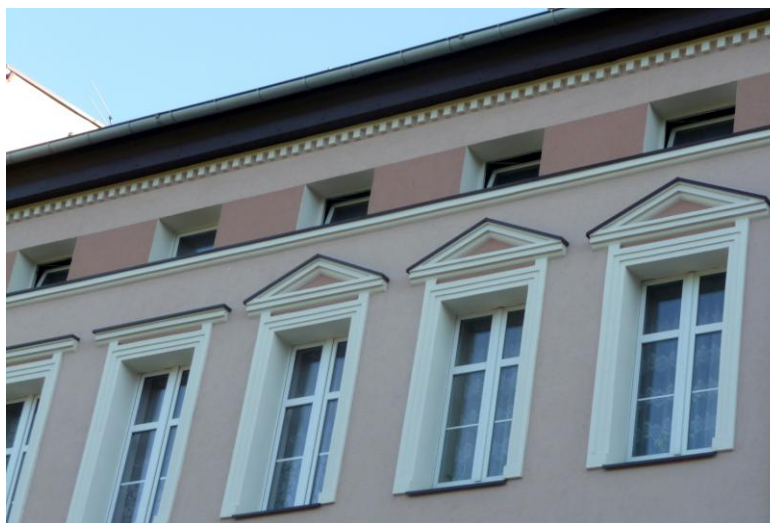
Otwory okienne elewacji frontowej
