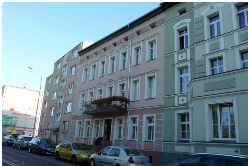
Widok budynku od północy
