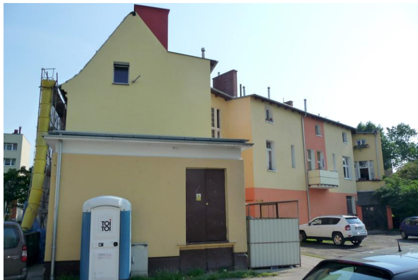
Widok budynku od północy
