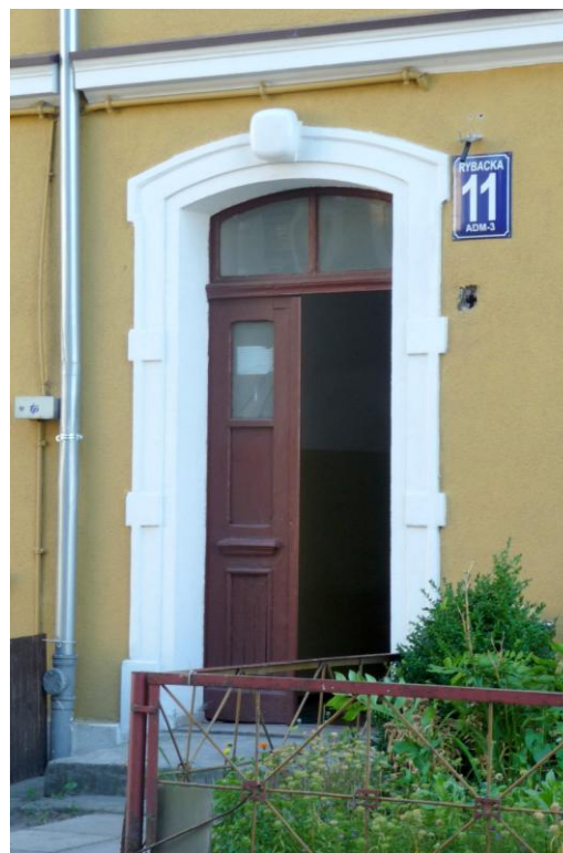
Portal drzwiowy w elewacji frontowej
