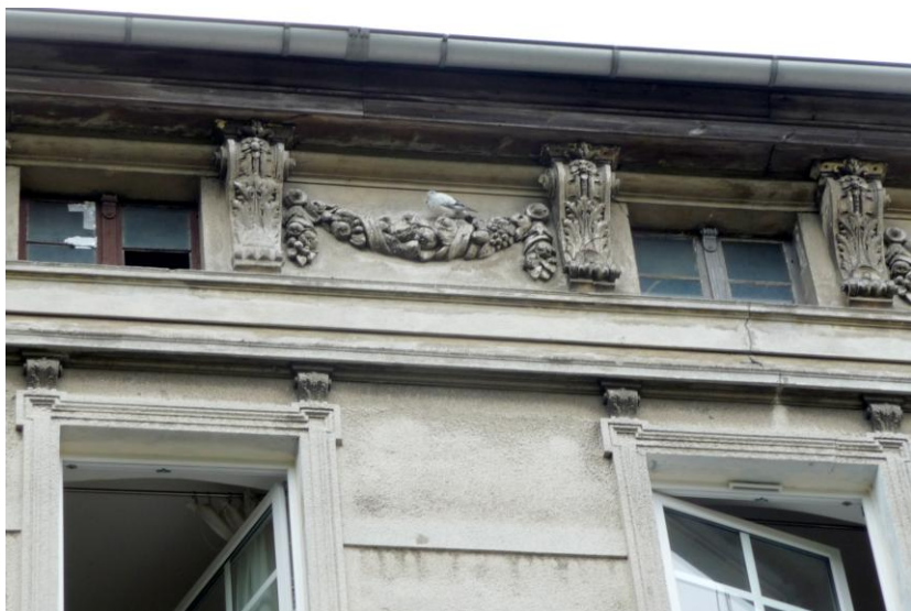
Konsole podtrzymujące gzyms, elewacja frontowa
