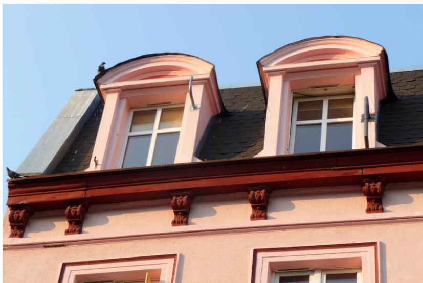
Lukarny frontowej połaci dachu
