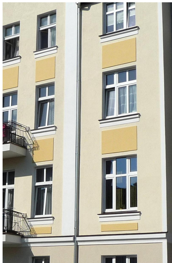
Otworki okienne w elewacji frontowej
