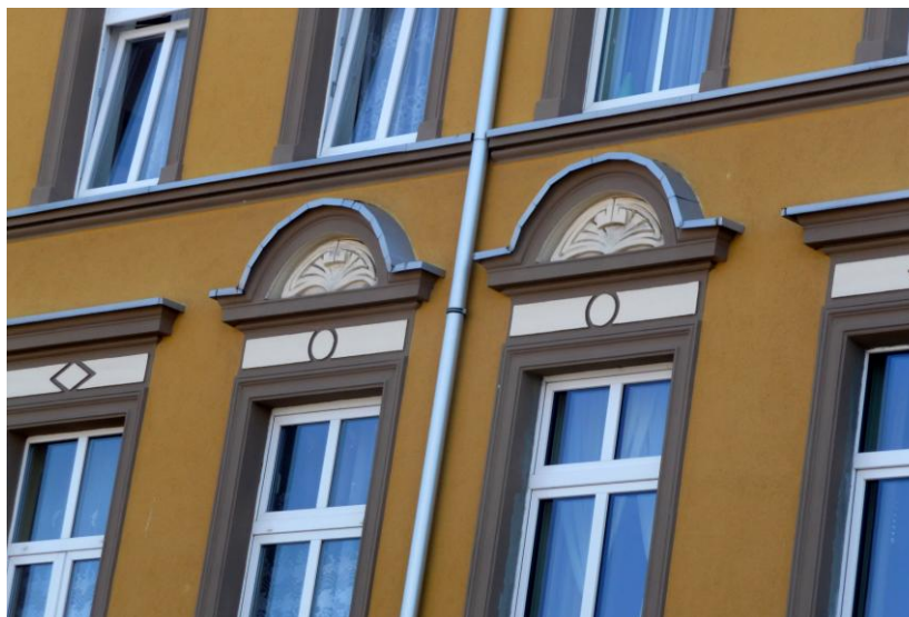
Otwory okienne w elewacji frontowej
