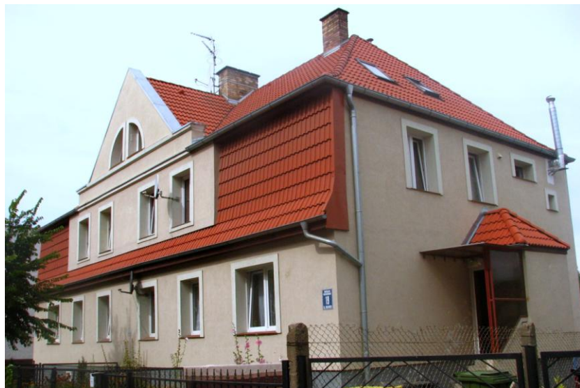
Widok budynku od południowego-wschodu
