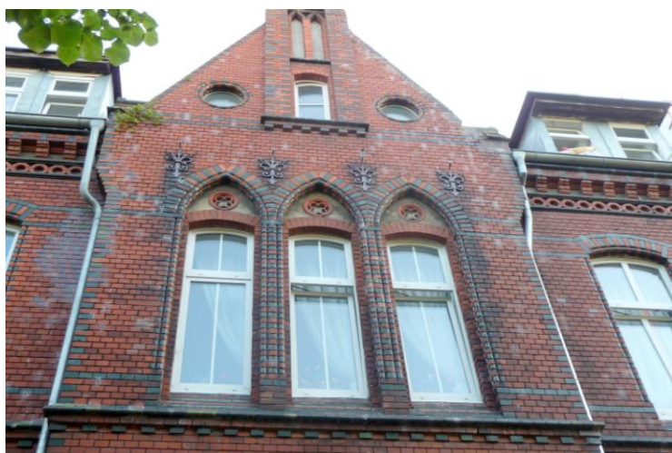
Otwory okienne ryzalitu w elewacji frontowej
