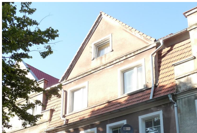
Facjata w frontowej połaci dachu
