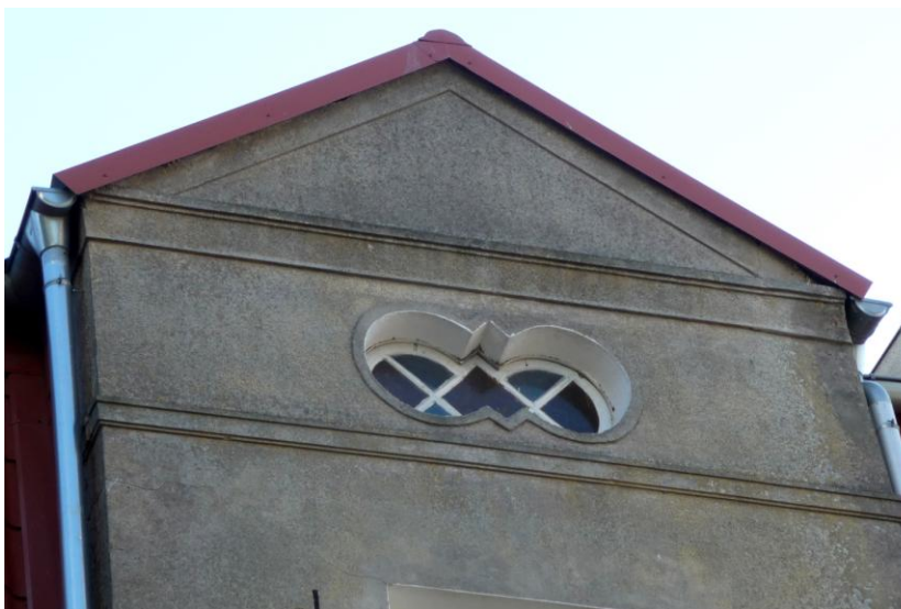
Szczyt ryzalitu klatki schodowej
