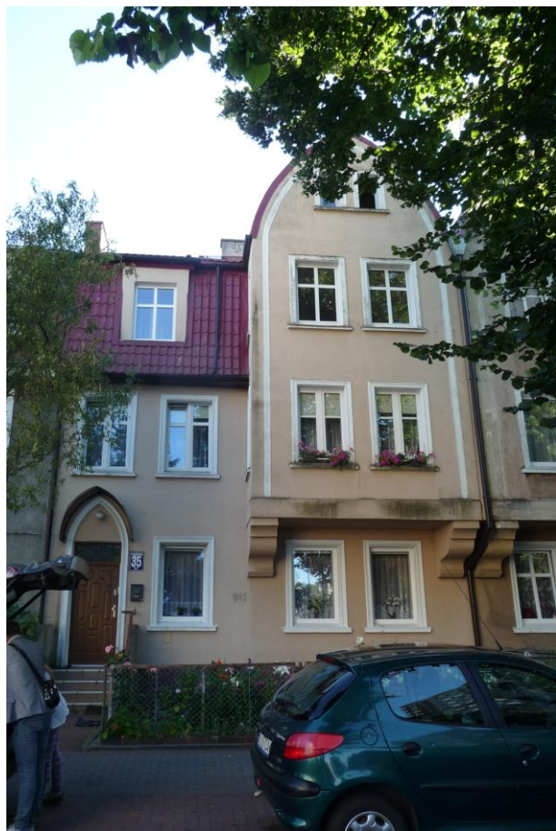
Widok budynku od północnego-wschodu
