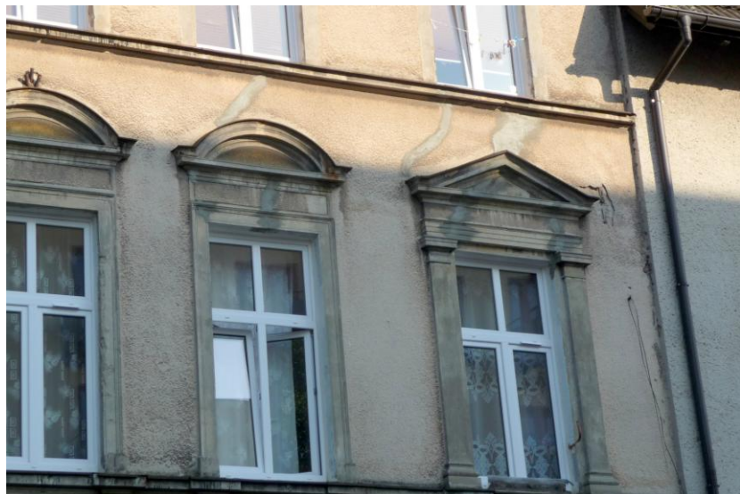
Otwory okienne elewacji frontowej
