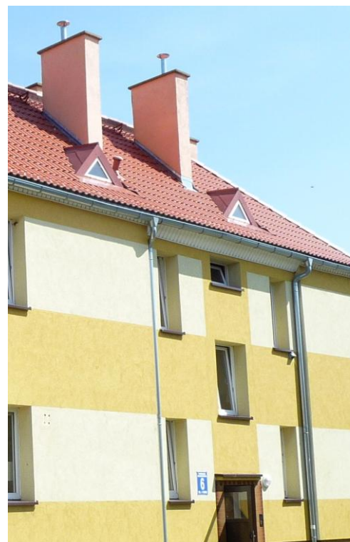
Część elewacji południowo-zachodniej
