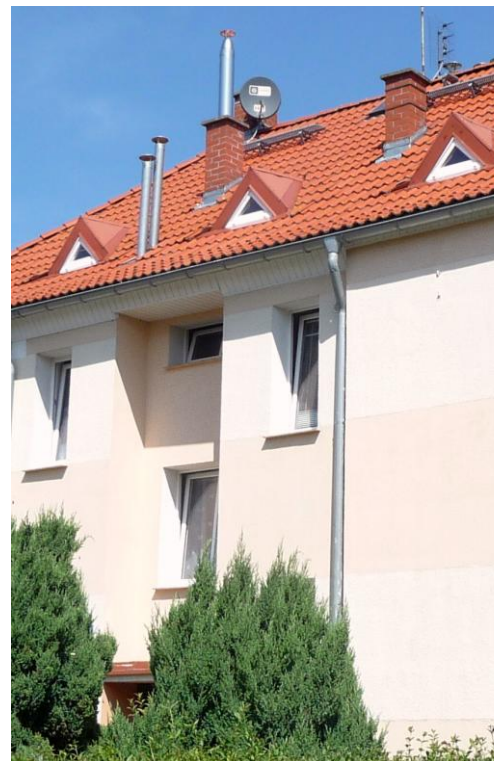
Część elewacji południowo-zachodniej
