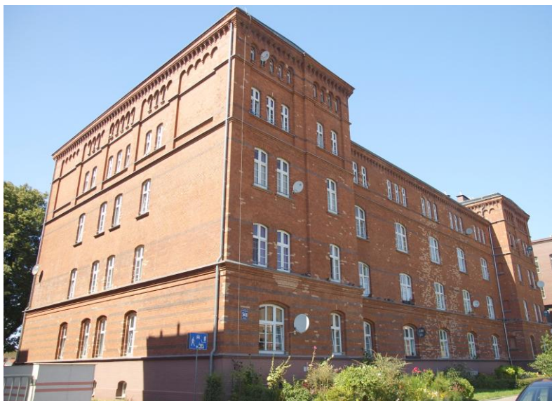
Widok budynku od południa
