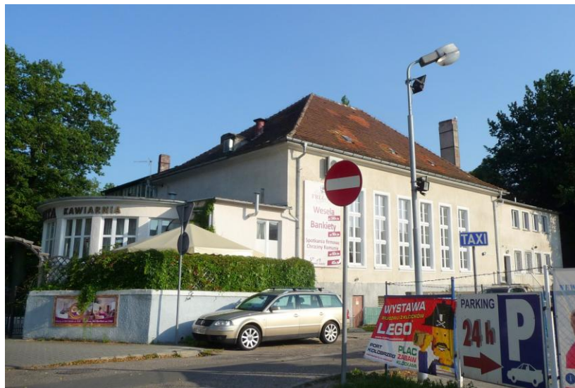
Widok budynku od północy
