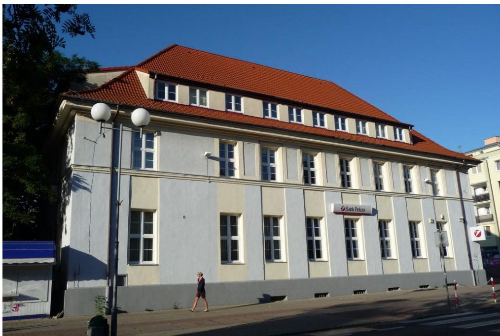
Widok budynku od południowego-zachodu
