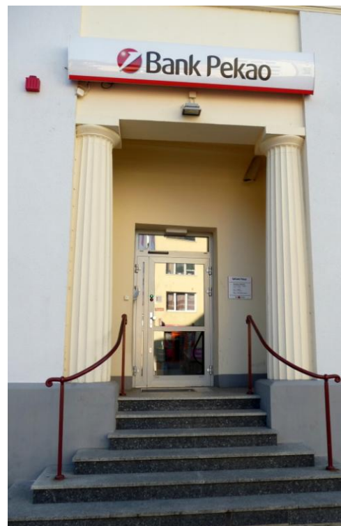
Wejście od ul. Łopuskiego
