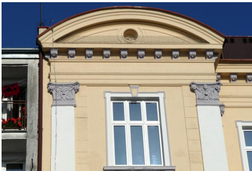
Zwieńczenie ryzalitu północnego, widok od zachodu
