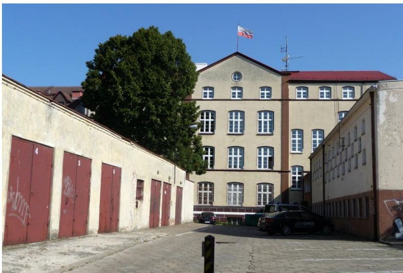
Widok budynku od północno-zachodu
