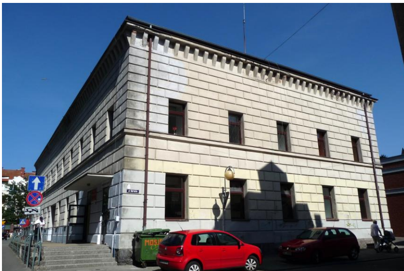
Widok budynku od południowego-zachodu
