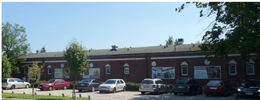
Widok budynku od północnego-zachodu
