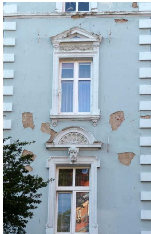
Otwory okienne elewacji frontowej
