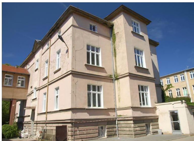
Widok budynku od południowego-wschodu
