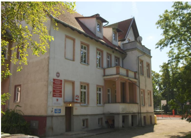
Widok budynku od północnego-zachodu
