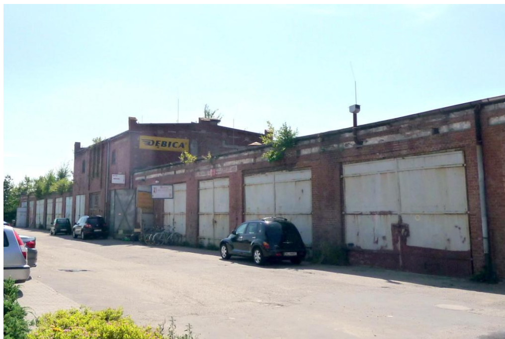
Widok budynku od północy
