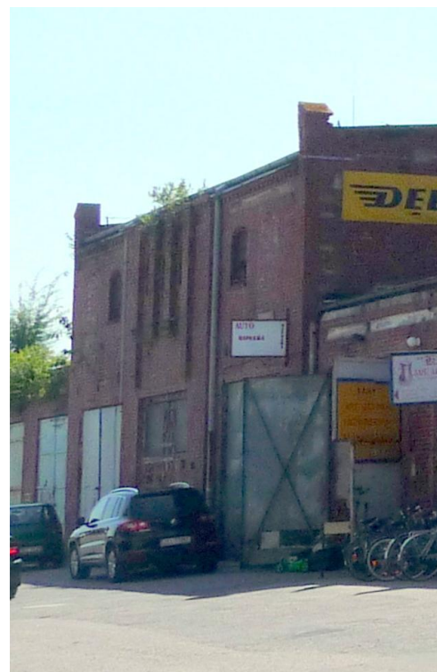
Część środkowa budynku, widok od północy
