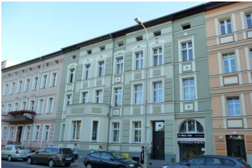
Widok budynku od północy
